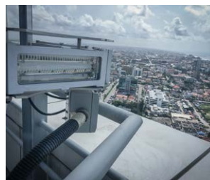
NIGERIA, Lagos, Eko Tower
